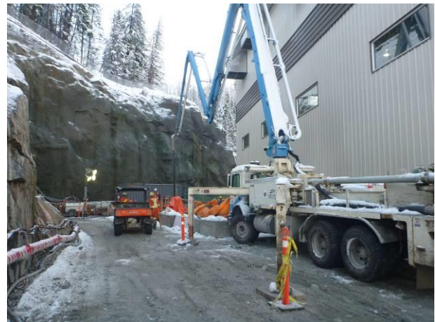
Photo 26 – Concrete pour on the BDRHEF bifurcation (November 28, 2016).
