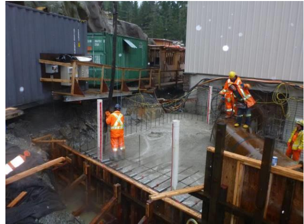
Photo 26 – Concrete pour on the BDRHEF bifurcation (November 14, 2016).
