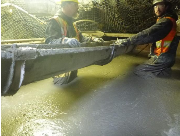
Photo 19 – Final concrete pour for the BDRHEF diversion tunnel plug (October 9, 2016).
