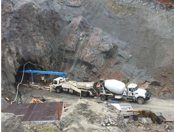
Photo 11 - Concrete pour for the lower-tunnel plug (October 18, 2016).
