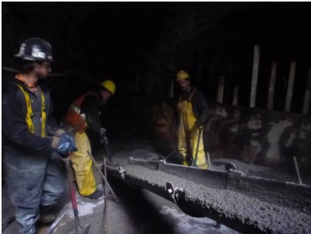
Photo 23 – Concrete pour for the upstream diversion tunnel plug (October 8, 2016).
