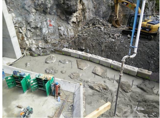
Photo 20 – Concrete pour for the BDRHEF Coanda downstream slab (September 20, 2016).
