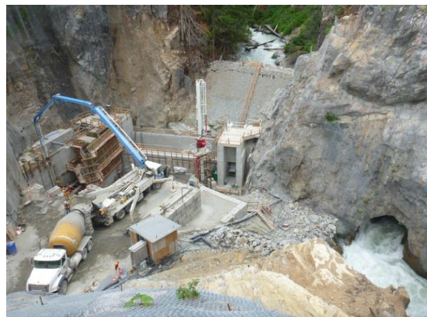
Photo 16 – Concrete pour at BDRHEF intake (August 21, 2016).
