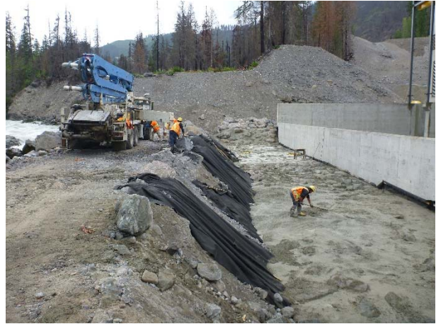
Photo 12 – Final pour of the ULRHEF grouted rip rap (August 2, 2016).
