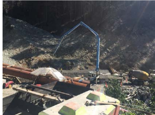
Photo 10 – Concrete pour for the Truckwash Creek crossing protection slab (August 11, 2016).
