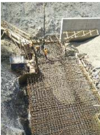
Photo 11– Concrete pour for the ULRHEF tailrace footing (June 5, 2016).
