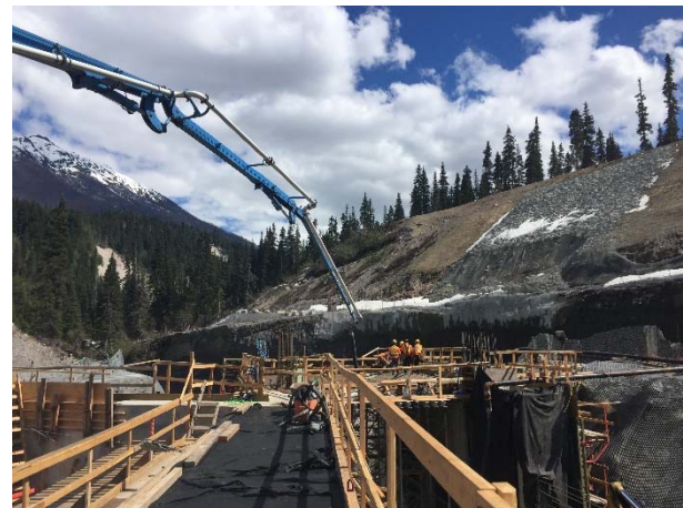
Photo 8 – Sluiceway structure concrete pour (May 12, 2016).
