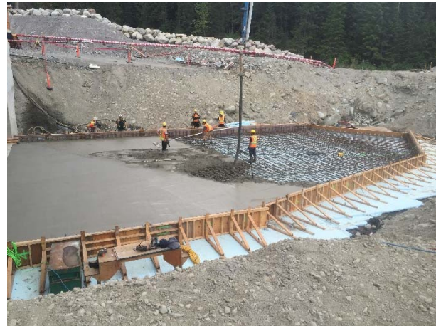
Photo 22 – BDRHEF tailrace concrete pour (May 18, 2016).
