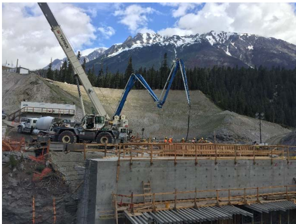
Photo 7 – Intake structure concrete pour (May 16, 2016).
