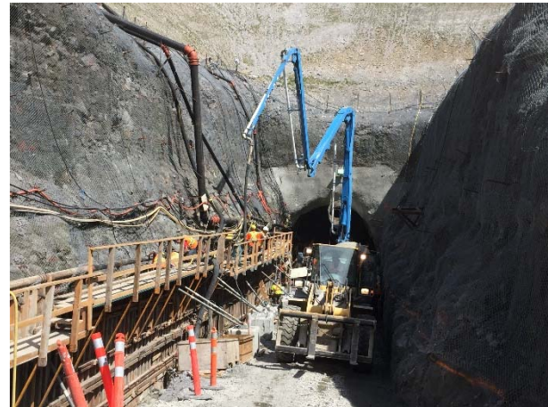
Photo 6 – Concrete arch foundation wall (BEBO) concrete pour (May 11, 2016).
