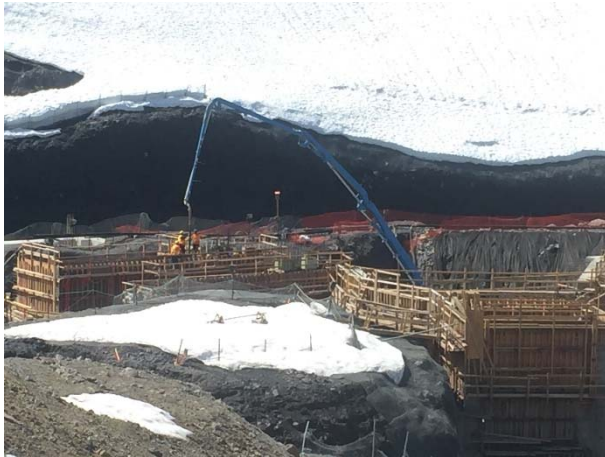
Photo 5 – Intake structure concrete pour (April 30, 2016).
