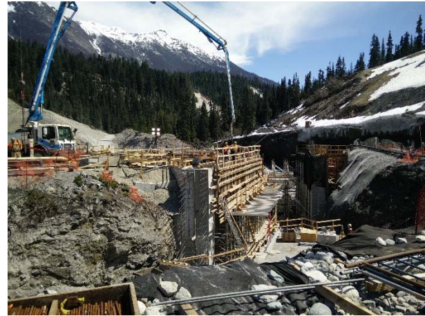
Photo 6 – Sluiceway concrete pour (May 7, 2016).
