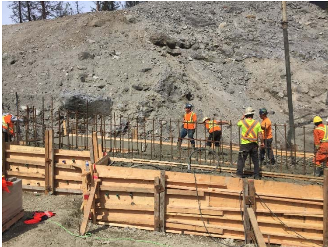
Photo 10– Concrete pour for the ULRHEF tailrace footing (April 21, 2016).
