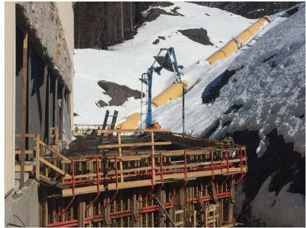
Photo 12 – Concrete pour for the powerhouse manifold (March 25, 2016).
