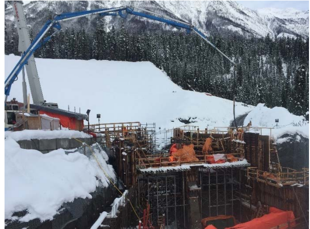
Photo 6 – Concrete pour at the ULRHEF intake (November 13, 2015).
