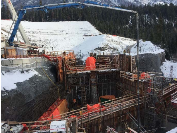
Photo 5 – Concrete pour at the ULRHEF intake (November 11, 2015).
