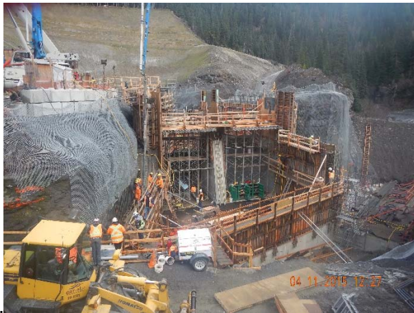
Photo 4 – Concrete pour at the ULRHEF intake (November 4, 2015).
