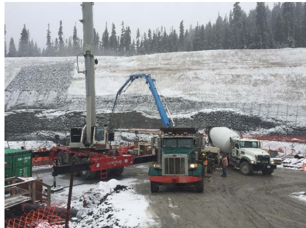
Photo 5 – Concrete pour at the ULRHEF intake (November 7, 2015).
