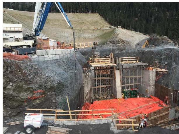
Photo 8 – Concrete pour at the ULRHEF intake (October 27, 2015).
