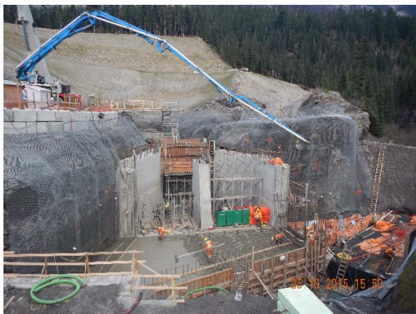
Photo 7 – Concrete pour at the ULRHEF intake (October 25, 2015).
