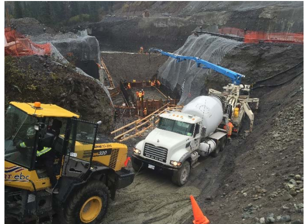
Photo 4 – Concrete pour at ULRHEF intake sluiceway location (October 21, 2015).
