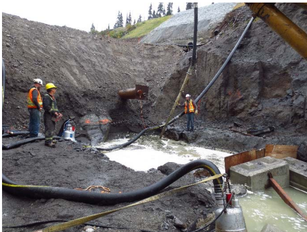
Photo 7 – Concrete pour at ULRHEF intake sluiceway location (October 8, 2015).
