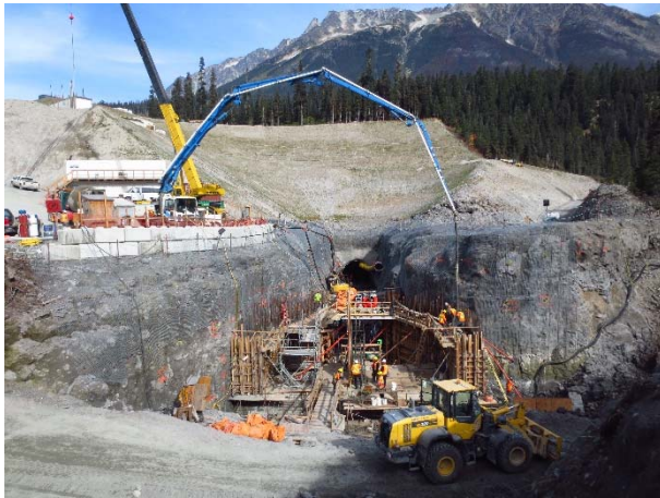
Photo 5 – Concrete pour at the ULRHEF intake (October 7, 2015).
