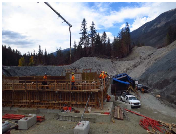
Photo 16 – Structural concrete pour at the ULRHEF powerhouse (October 6, 2015).
