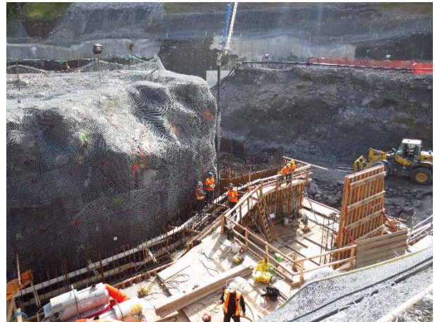
Photo 6 – Concrete pour at the ULRHEF intake (October 7, 2015).
