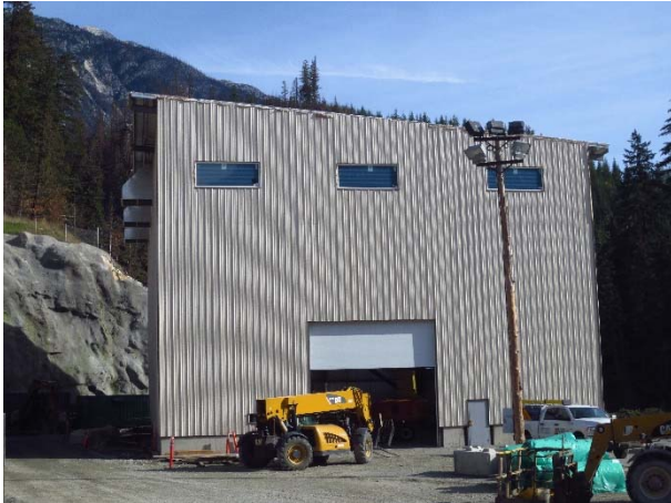
Photo 19 – BDRHEF powerhouse structure (October 5, 2015).
