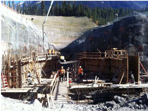
Photo 1 – Concrete pour at the ULRHEF intake (October 3, 2015).
