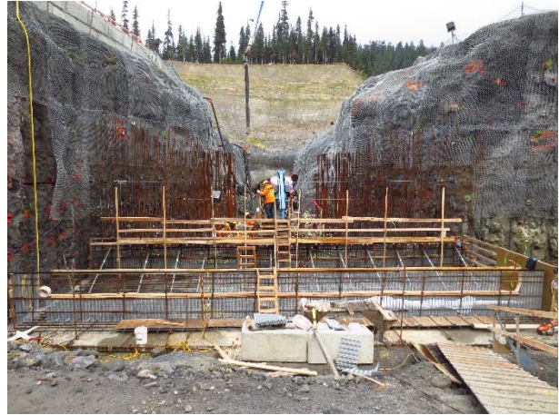
Photo 5 – Concrete pour at ULRHEF intake (September 23, 2015).
