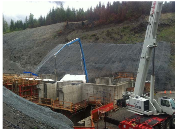
Photo 17 – Structural concrete pour at the ULRHEF powerhouse (September 18, 2015).
