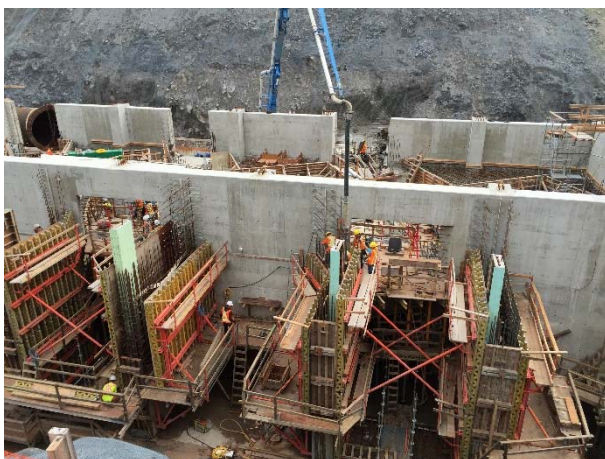
Photo 18 – Concrete pour at ULRHEF powerhouse (September 7, 2015).
