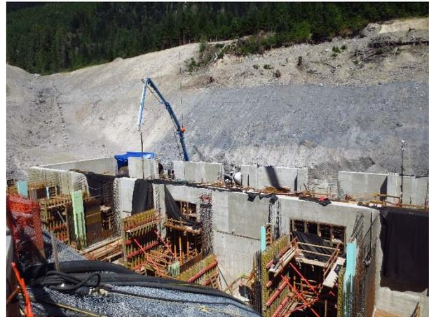
**Photo 12 – Concrete pour at ULRHEF powerhouse (June 21, 2015).**
