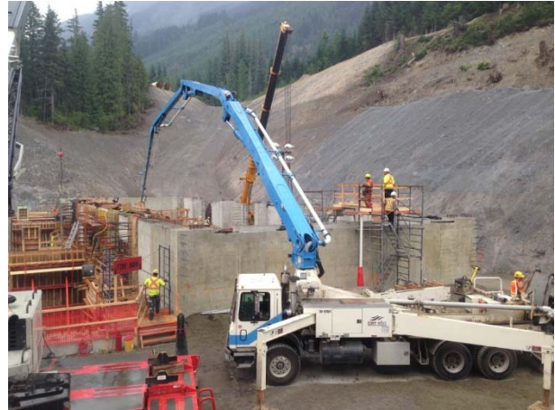
Photo 14 – Concrete pour at ULRHEF powerhouse (June 18, 2015).
