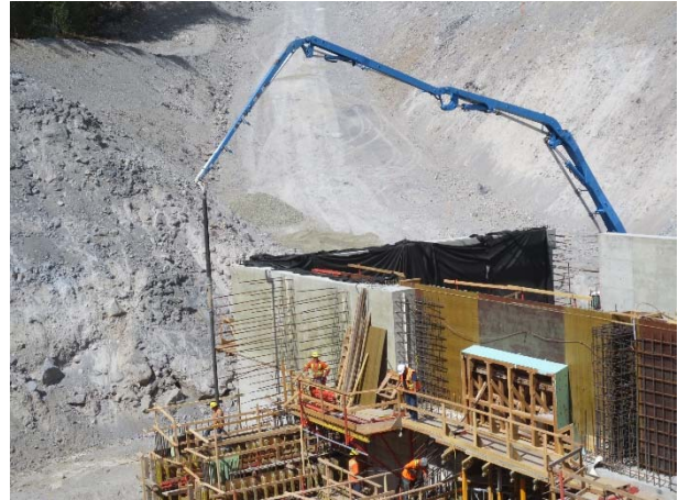
Photo 12 – Concrete pour at ULRHEF powerhouse (June 10, 2015).
