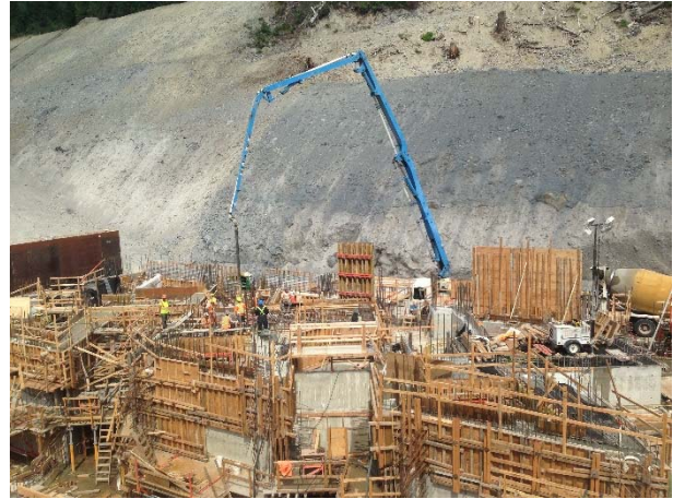
Photo 17 – Concrete pour at ULRHEF powerhouse (May 26, 2015).
