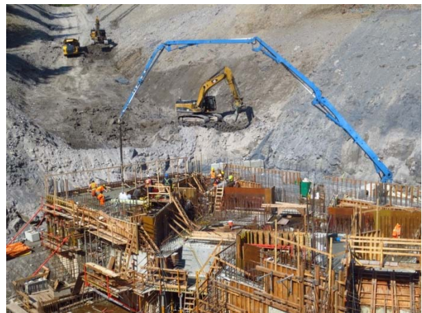
Photo 19 – Concrete pour at ULRHEF powerhouse (May 17, 2015).
