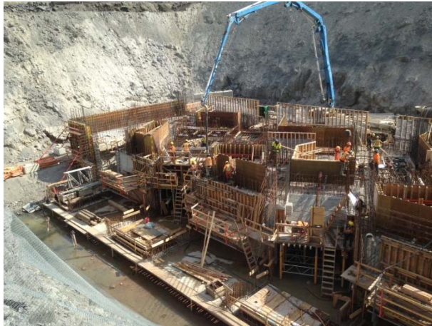
Photo 17 – Concrete pour at the ULRHEF powerhouse (May 10, 2015).
