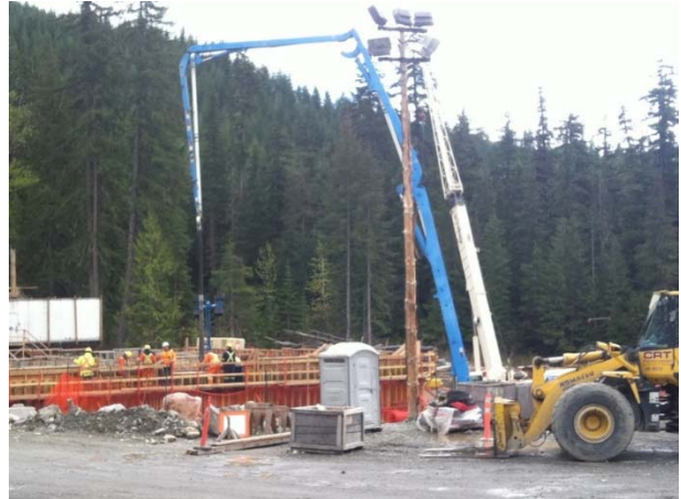
Photo 21 – Structural concrete pour at the BDRHEF powerhouse (April 29, 2015).
