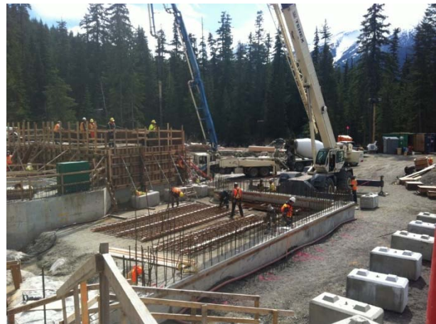
Photo 5 – Concrete pour in progress at BDRHEF powerhouse (April 15, 2015).
