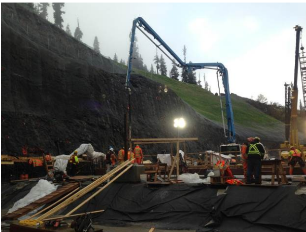
Photo 3 – ULRHEF Obermeyer weir concrete pour (October 17, 2014).
