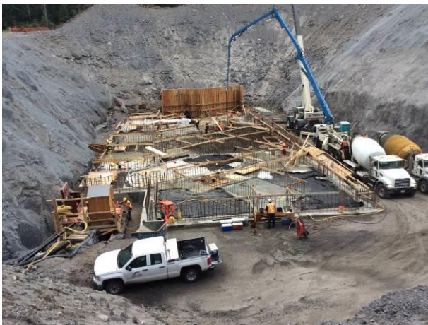
Photo 9 – Concrete pour for ULRHEF powerhouse foundation (September 22, 2014).
