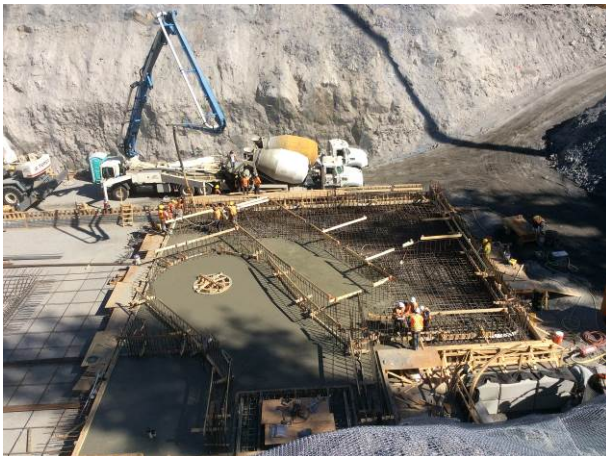
Photo 9 – Concrete pour for ULRHEF powerhouse foundation (September 16, 2014).
