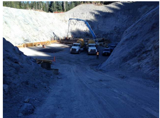
Photo 12 – Concrete pour for ULRHEF powerhouse foundation (September 10, 2014)
