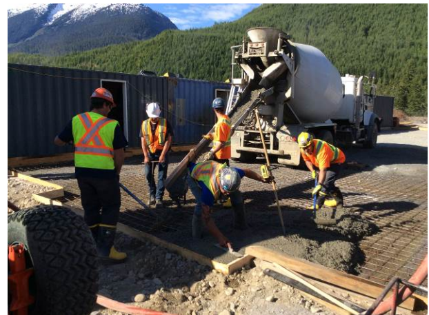
Photo 2. Concrete pour of the future mechanic shop
